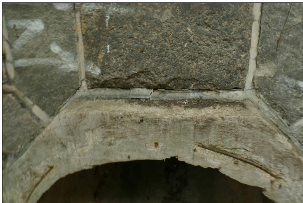
Obr. č. 6 - pohled na popraskané a vypadávající spárování na levém čele
