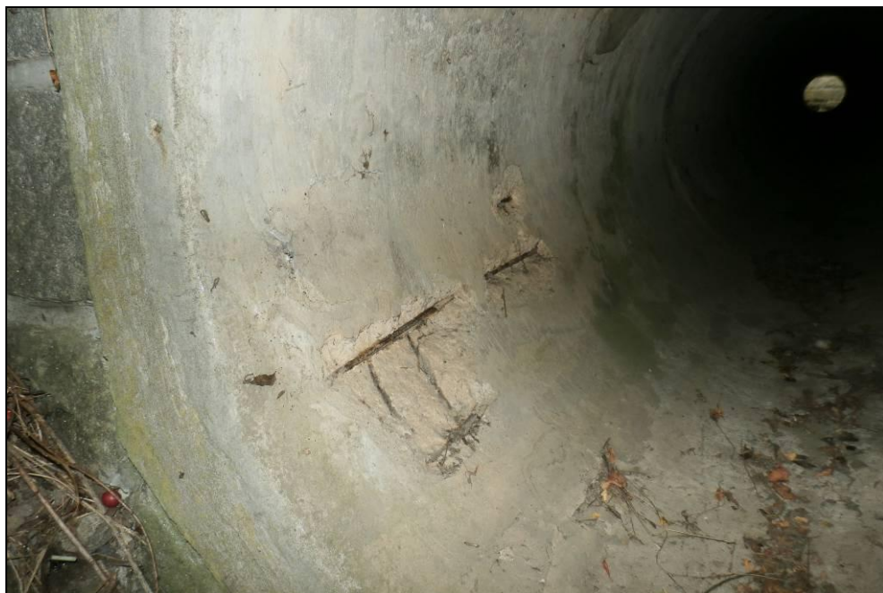
Obr. č. 5 - pohled na líc výtokové roury - opady betonu do hloubky až 2 cm
